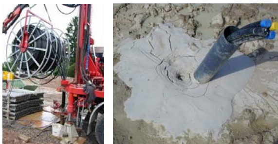
Abbildung 1 Einbau und Verpressen einer Erdwärmesonde
