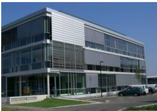
Abb.1: Gebäude PBT, Südost-Fassade
