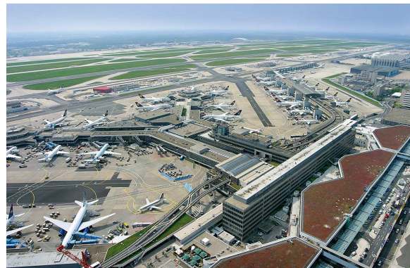
Abbildung 1 Terminal 1, Frankfurt Foto: Fraport AG
