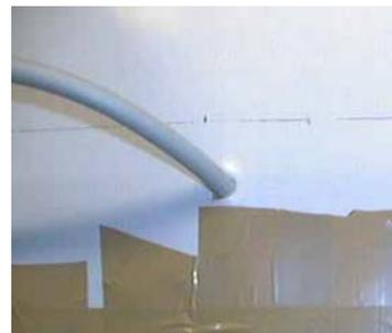
Abbildung 3: Nicht abgeklebte Durchdringung eines Elektrokabels durch die Dampfbremse [10].
